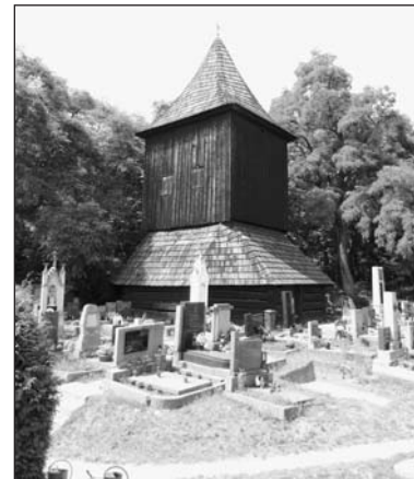
Zvonice na Zámečku.
